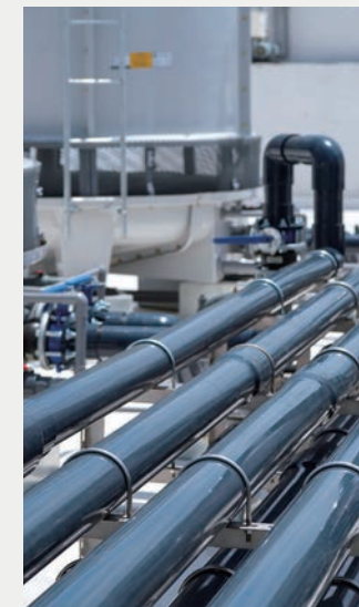
冷凍空調工程 Air Conditioning project
