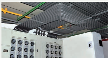
電導管工程 Electrical engineering
