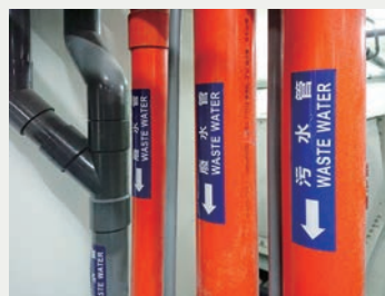
下水道工程 Sewer Engineering
